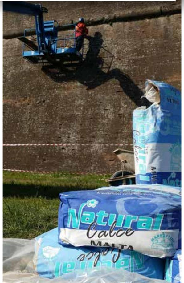
**Rinzaffo naturale e traspirante pronto all'uso per l'esecuzione di schizzate aggrippanti con capacità antisalina su pietra, laterizi, murature miste, tufo etc. prima dell'applicazione di intonaci della linea "NATURAL CALCE".**
