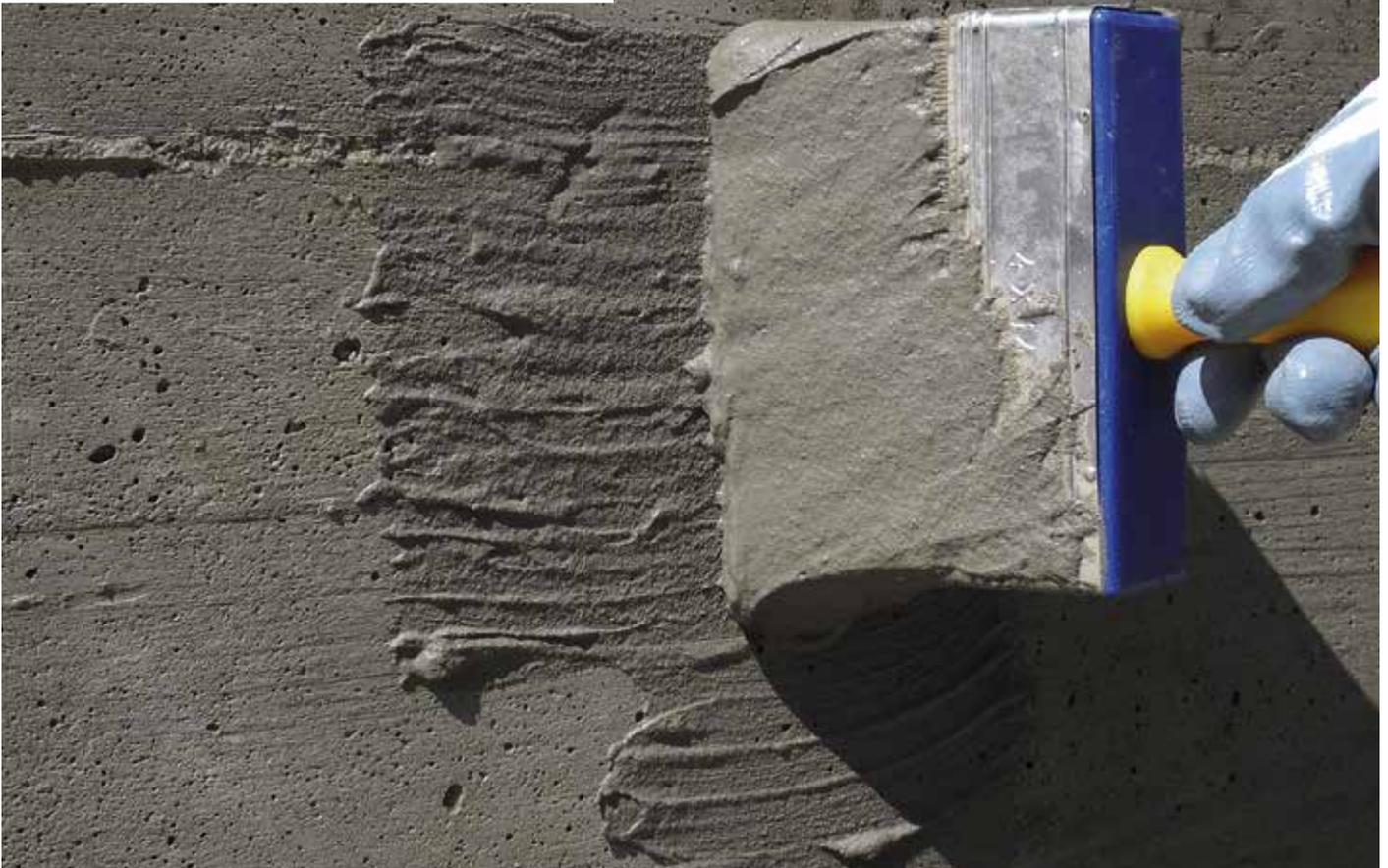
Malta-intonaco impermeabilizzante e di regolarizzazione ad azione osmotica, fibrorinforzata, resistente ai solfati a ritiro controllato ed alta adesione, applicabile a spessore su molteplici tipologie di supporti.
