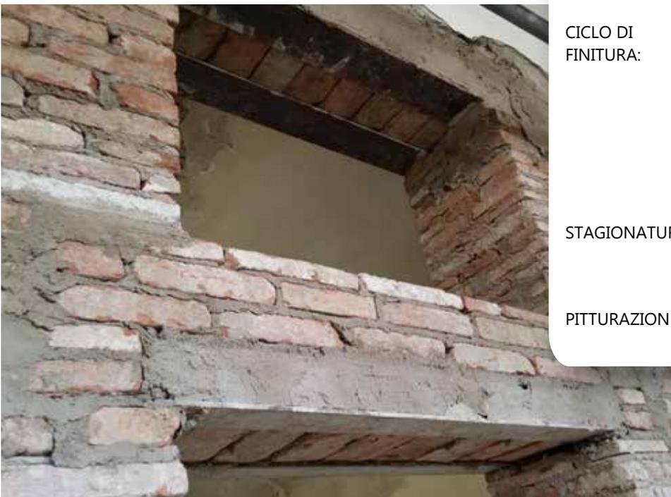
**Intonaco naturale pronto all'uso, per l'esecuzione di intonaci di fondo ad elevata traspirabilità e lavorabilità.**
